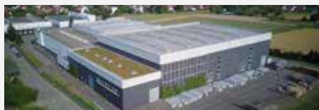
Hugo Brennenstuhl GmbH & Co. KG Werk 2 / Plant 2
