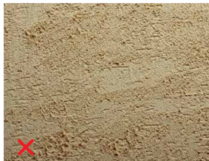
CT16 alapozó festék kihagyásával készült „dörzsölt” hatású vakolat
