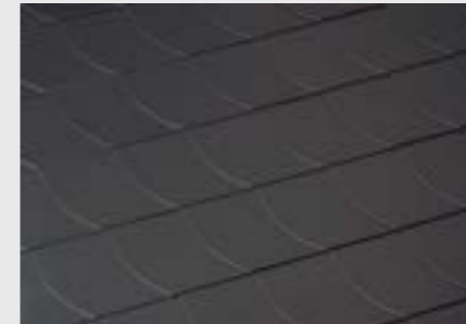
bogen ívívágású palafedés (30×30 cm)
