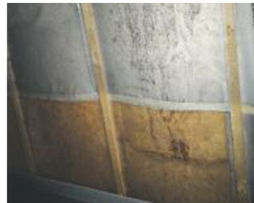
Benyirkosodott fa hagyományos párazáró réteggel.
