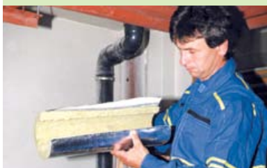
Orstech csőhéj szigetelés beszerelés előtt.
