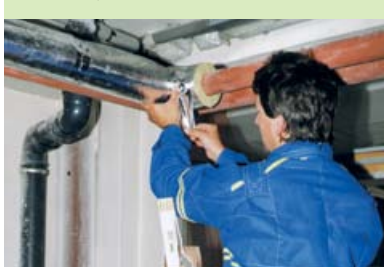
Sarokcsatlakozás alumínium ragasztószalaggal történő átragasztása.
