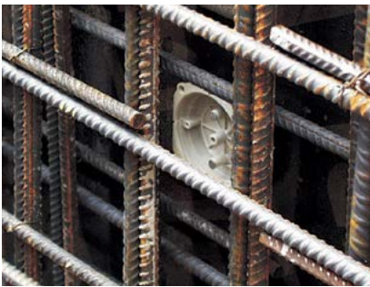
A zsaluzatra erősített KBV fedél.
