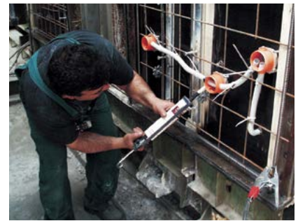
Az átvezetések tömítése (gitt).
