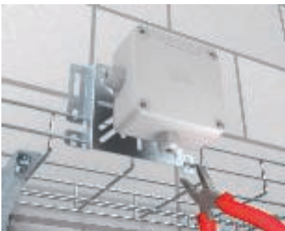
Szerelőlap Az MP UNI szerelőlap csavar nélküli gyors rögzítése.
