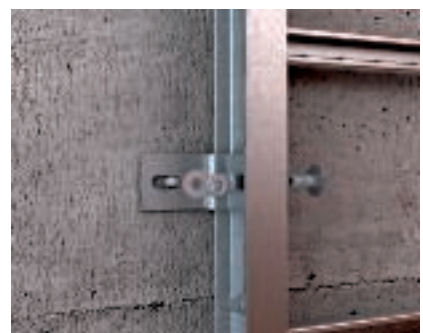
Ipari kivitelű kábelhágcsók rögzítése Az ipari kábelhágcsó a BW 80 55 FT típusú rögzítőszegletekkel rögzíthető a falra.
