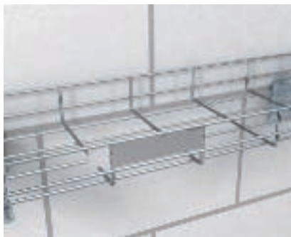
Jelölőtábla KS-GR típusú jelölőtábla szerelése a rácsos kábeltálca oldalára.
