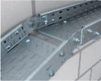
Kábeltálcák függőleges csuklós összekötése Kábeltálcák függőleges csuklós összekötése kivitelezéskor készített tetszőleges szögű szint-ugrásoknál.
