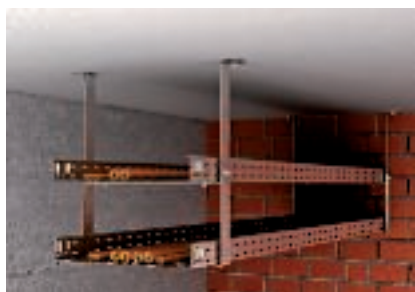
Kétszintes mennyezeti szerelés födémkengyellel és toldóval
