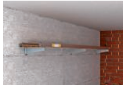
Vezetékek rögzítése oldalfalra
