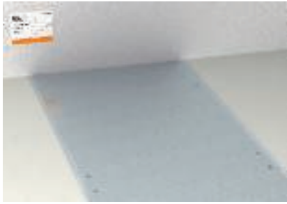
Láthatatlan tűzgátló tömítés esztrichel színélő csatornában
