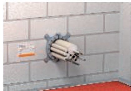
Védőcső-köteg jelöléssel ellátott tűzgátló tömítése
