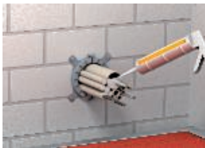
A csővégek kitöltése DSX masszával
