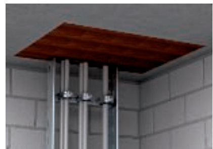
A blokkok födémáttörésbe szorosan illeszkedő beépítése
