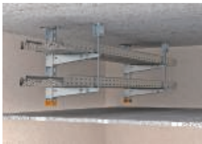
Kétszintes földműfüggesztés, egy oldalon elhelyezett konzolokkal
