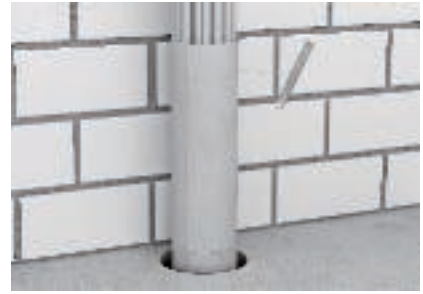
A bandázs rögzítése kötöződróttal
