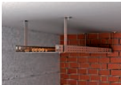
Mennyezetre szerelés függesztőkengyellel, egyszintes
