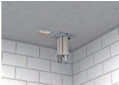
Szerelés a földem alsó részén, fémdübelekkel
