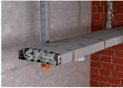
A függesztett kábeltálca teljes be- tekerése
