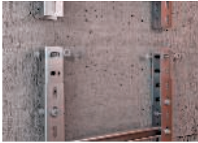
Toldáspont csavarozott összekötővel
