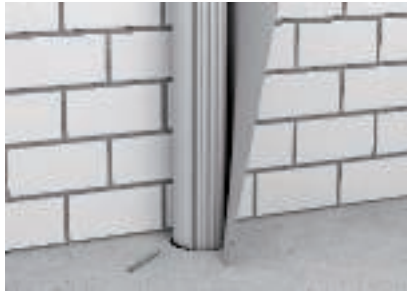
A tűzvédelmi bandázs installálása
