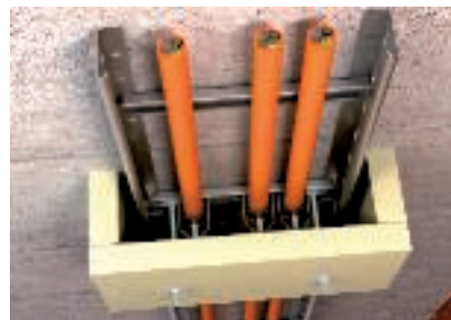
A húzásmentesítő szerelése kábelhágcsón
