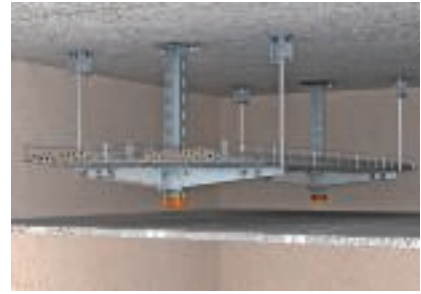
Kétszintes földmfüggesztés kétoldali konzolelhelyezéssel
