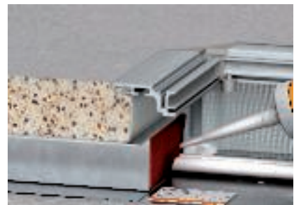
A kábelek és a blokkok közötti rések lezárása FBA-SP réstömítővel
