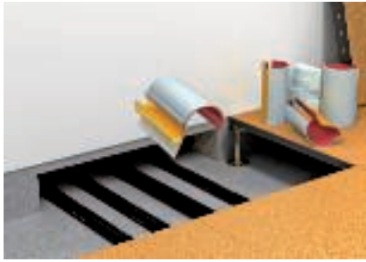
A félcső szerelése
