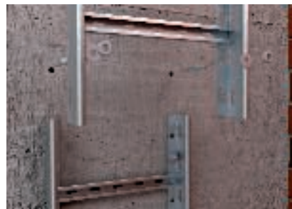
Toldás kialakítása hosszoldó nélkül
