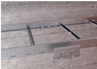
A hosszitoldó szerelése félgömbfejű csavarokkal
