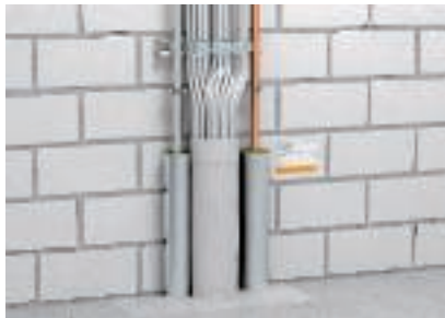
A tűzvédelmi bandázs installálása nulla távolsággal a Rockwool Conlit csőtömítéshez
