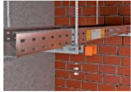
Menetes rúd szerelése hatlapfejű anyával és nagyméretű alátéttel
