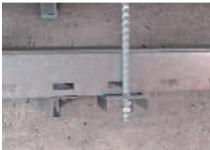
A függőleges menetes rúd rögzítése a csatlakozóelemhez
