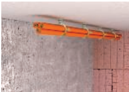
Kötegelt kábelhelyezés a mennyezet alatt
