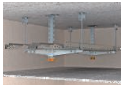
Kétszintes földműfüggesztés kétoldali konzolelhelyezéssel
