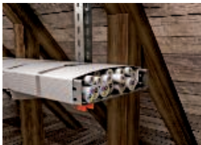
Bandázsolás alkalmazása nagy tűzterhelésű környezetben
