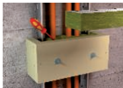
Kőzetgyapot-töltet a rugalmas kábelvezetéshez
