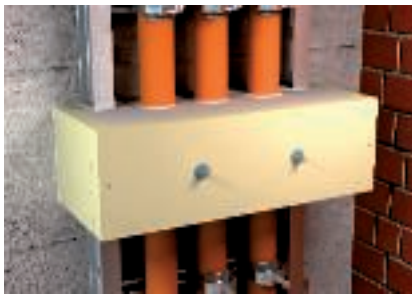
Hatásos alátámasztás ZSE90 húzásmentesítővel
