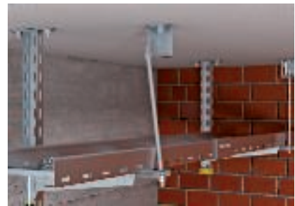
A menetes rúd beakasztása a tűzvédelmi földémkengyelbel
