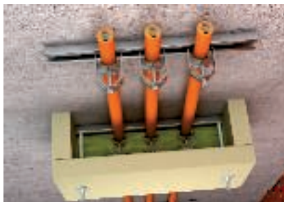
A húzásmentesítő szerelése profilsínen rögzített kábeleken
