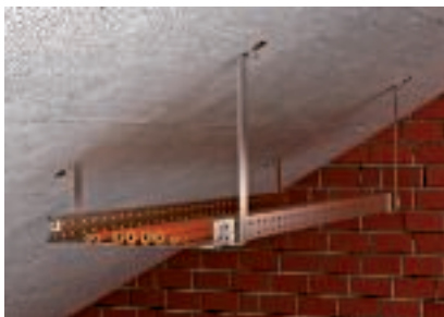
Szerelés dőlt mennyezetre, egyedileg igazított födémkengyellel
