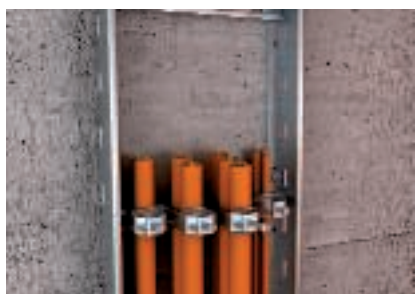
Kábelek rögzítése egyenként vagy csoportosan, kengyeles bilincsekkel
