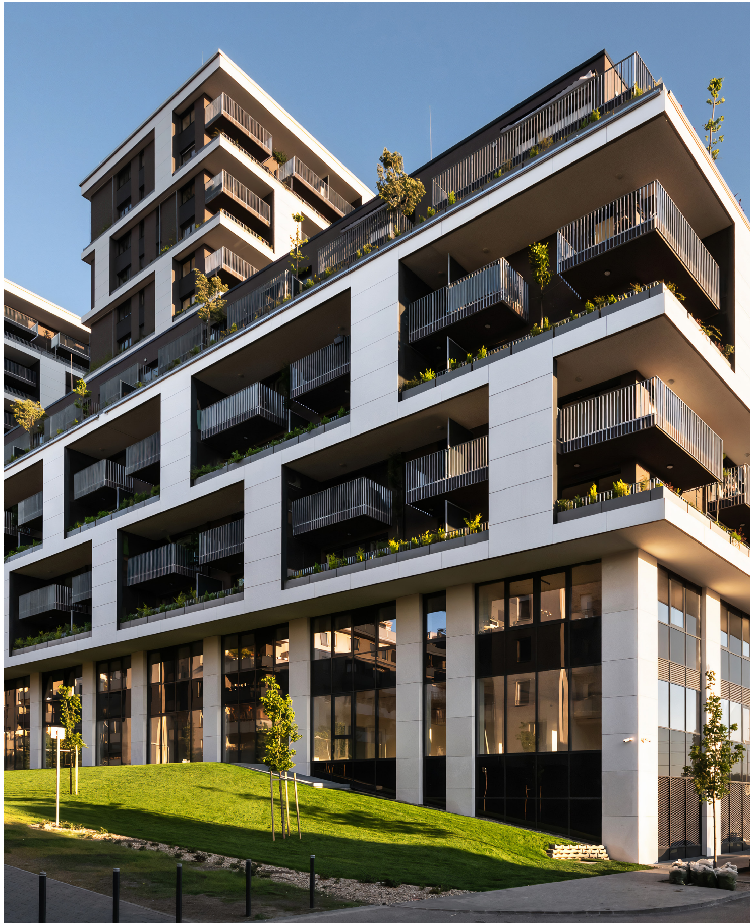
Metrodom Panoráma lakópark
