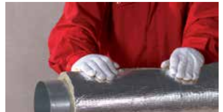
2. lépés – A szigetelés ráhajtása a csatornára
