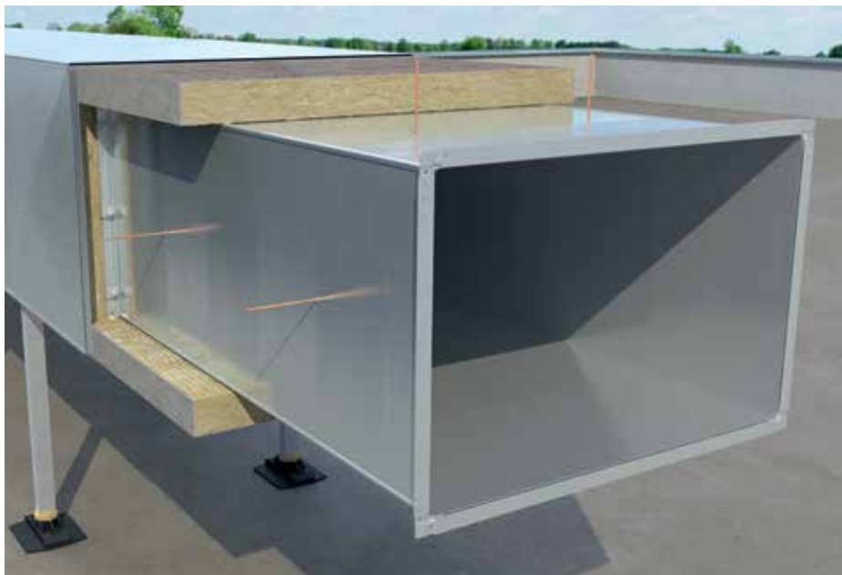
Külsőben vezetett légcsatornák szigetelését az időjárás hatásaitól védő burkolattal kell ellátni, pl. lemezburkolattal.
