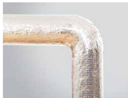
14. kép – Elkészült szigetelés PIPO ALS csőhéjjal
