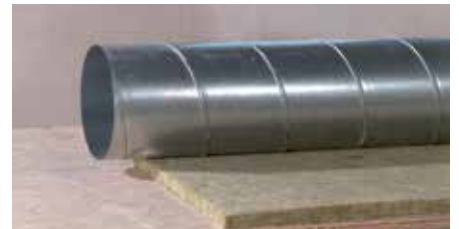
1. lépés – A szigetelés pontos méretre vágása
