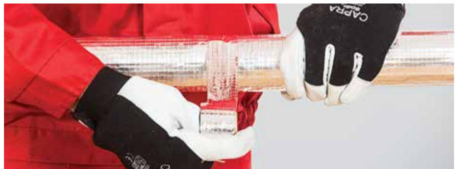
4. kép – Illesztések lezárása alumínium szalaggal
