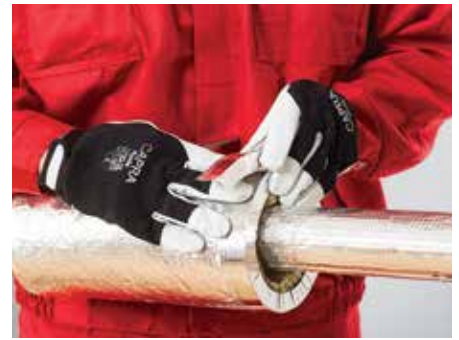
22. kép – A szigetelés lezárása alumínium szalaggal
