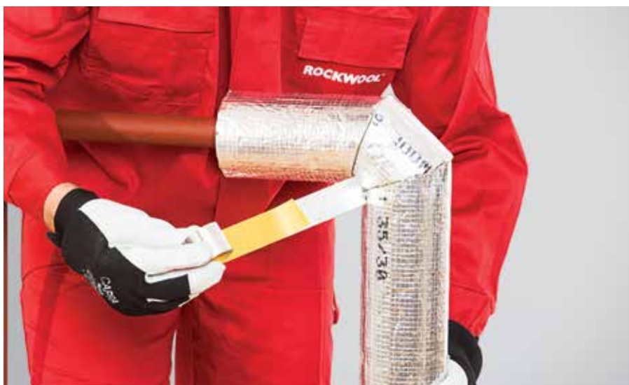
13. kép – Illesztések összeragasztása alumínium öntapadó szalaggal
