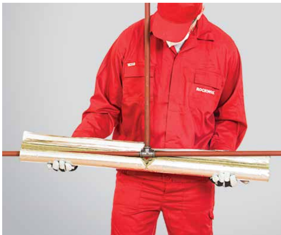
17. kép – Elemek felhelyezése a T elágazás száraira
