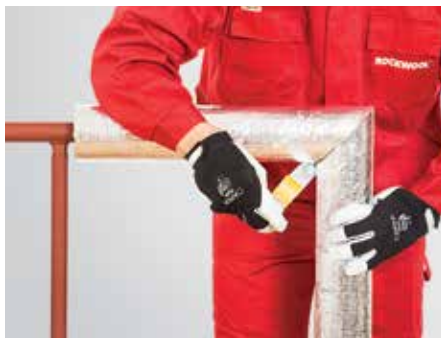
8. kép – Csatlakozások lezárása öntapadó alumínium szalaggal
