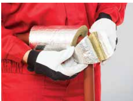
11. kép – Egy szegmens felhelyezése
