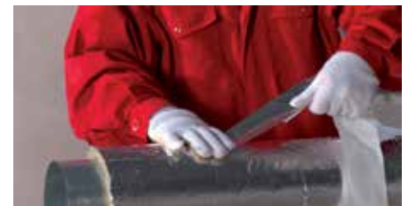
3. lépés – A hossz- és keresztirányú illesztések leragasztása öntapadó alumínium szalaggal
