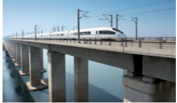
BETONJAVÍTÁS ÉS SZERKEZETMEGERŐSÍTÉS
